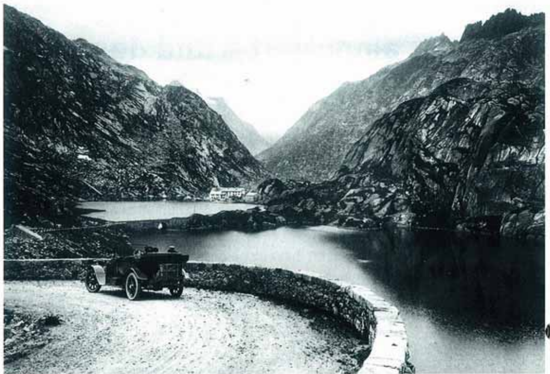
Abb. 3: Die Grimselstrasse um 1921. Im Hintergrund sind die Damm- und Brückenkonstruktion über den ehemaligen Grimselsee und das alte Hospiz sichtbar (aus: Zinggeler 1991).
