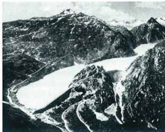
Abb. 1 und 2: Die Grimsellandschaft vor und nach der Anlage des Stausees. Deutlich sind die Folgen für den alten Saumweg und die Fahrstrasse von 1894 sichtbar (aus: Gurtner, Jahn 1939).
